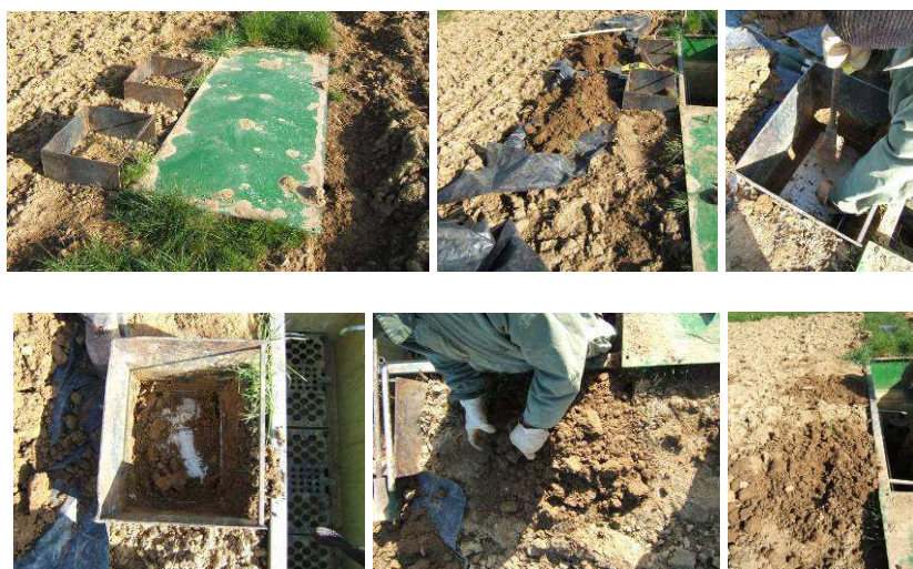
Photographie 14. Remise en place des dispositifs enterrés de collecte des eaux gravitaires (avril 2005)
