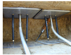
Installation de lysimètres à mèches (avant recouvrement)
